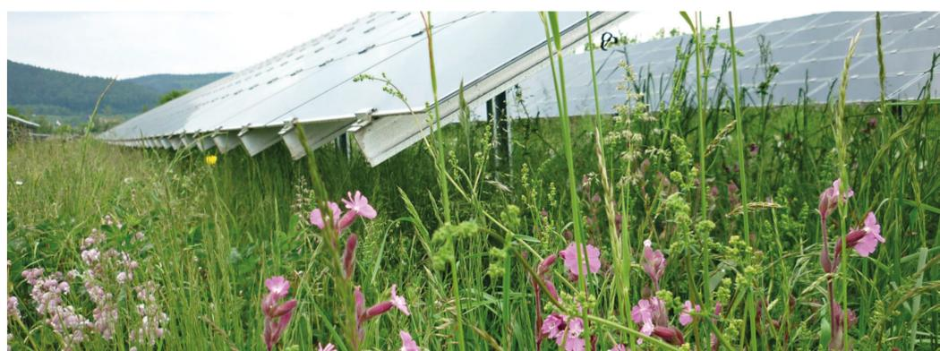
Um möglichst wenig Fläche zu versiegeln, empfiehlt es sich, die Module zu rammen. Ein Bewuchs ist mit ausreichend Platz zum Boden und zwischen den Modulen gut möglich und Pflege- und Wartungsarbeiten werden erleichtert.
