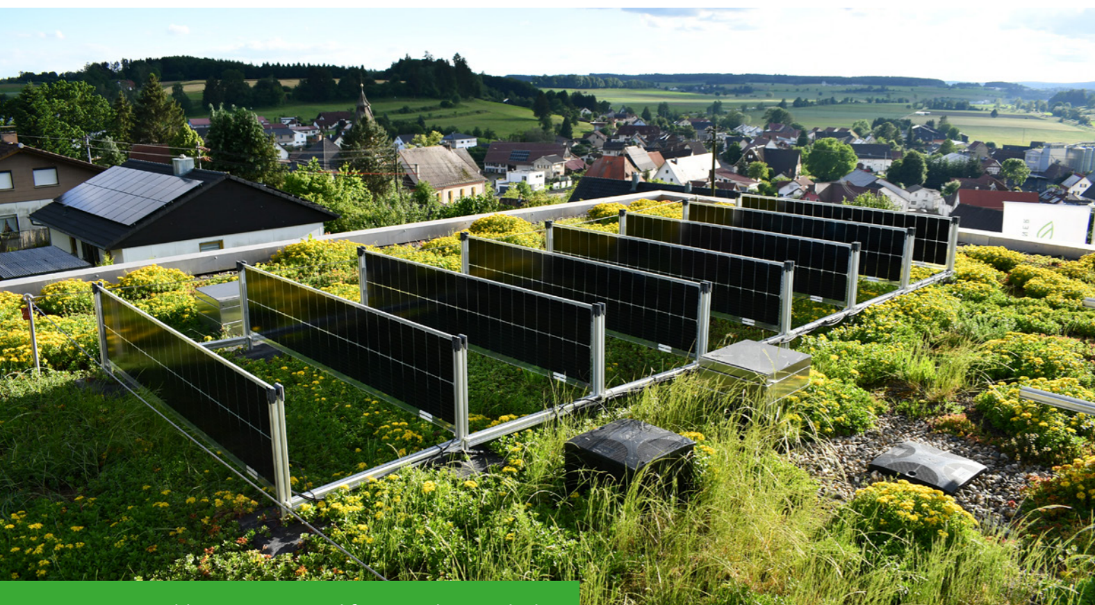
Abb. 13: Ein Beispiel für ein Solargründach mit senkrechter Aufstellung. Quelle: BuGG
