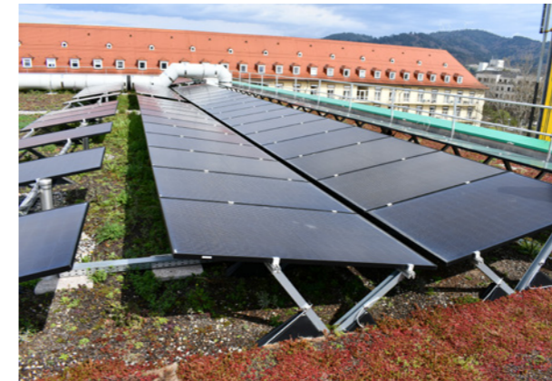
Abb. 16: Ein Beispiel für ein Solargründach mit Ost-West-Ausrichtung in „Schmetterlingsbauweise“. Quelle: BuGG
