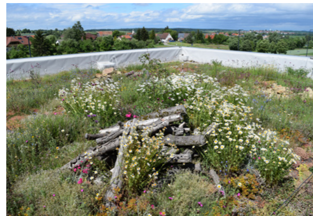
Abb. 6: Ein Beispiel für ein Biodiversitätsgründach mit hoher Arten- und Strukturvielfalt. Quelle: BuGG
