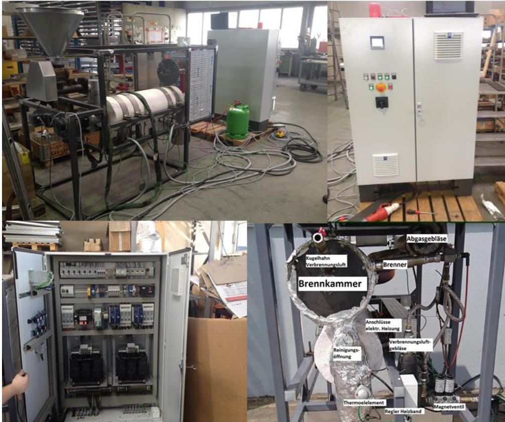
Abbildung 14: Unterschiedliche Bauabschnitte des PYREKA Laborsystems; links oben: Keramikrohrheizungssystem, rechts oben und links unten: Außen- und Innenansicht des Schaltschranks für die Anlagensteuerung, rechts unten: Seitenansicht des Laborsystems
