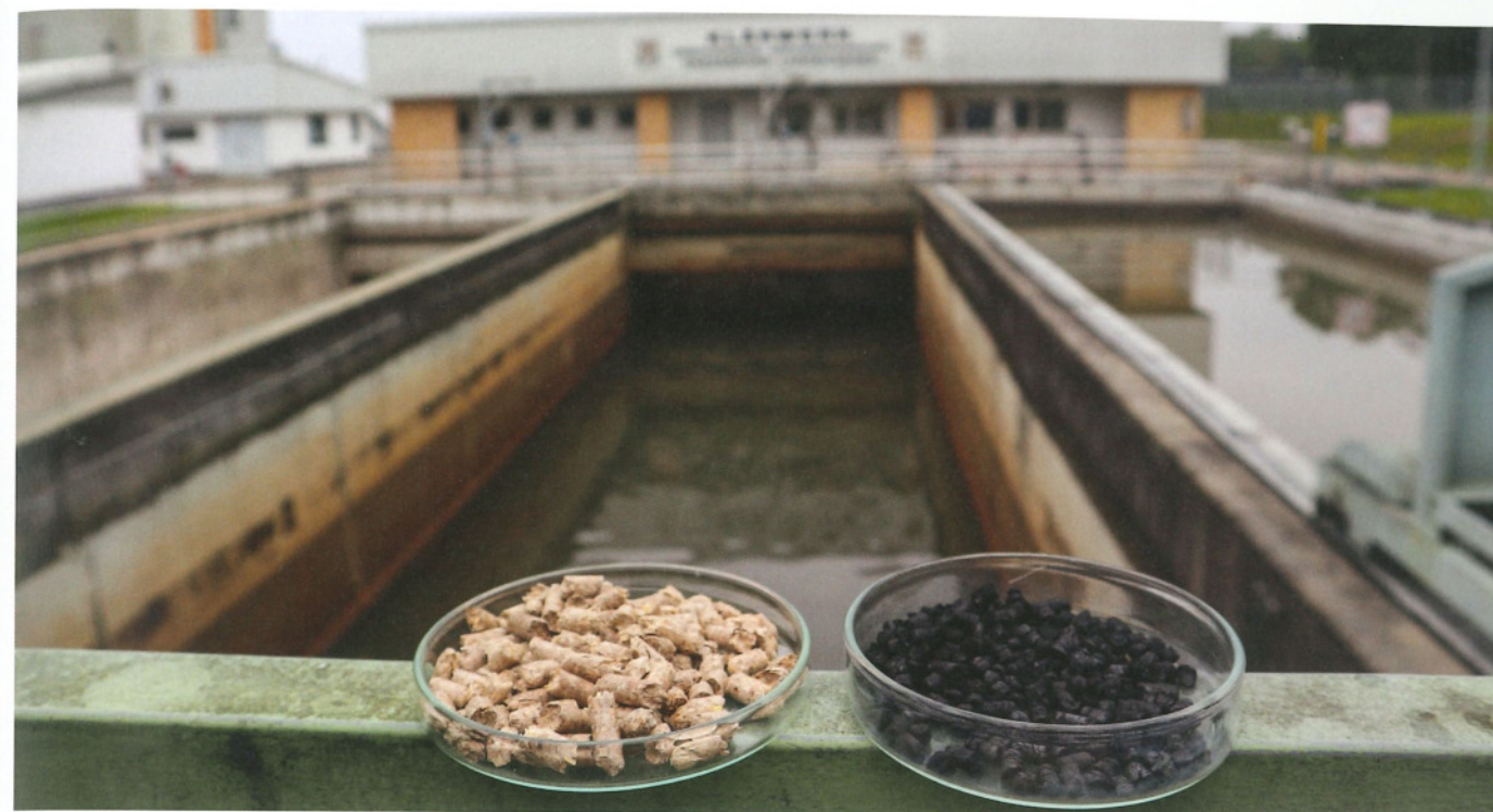
Ab Frühjahr 2023 soll auf der Kläranlage Kressbronn a. B. – Langenargen versuchsweise Aktivkohle aus Reststoffen eingesetzt werden
